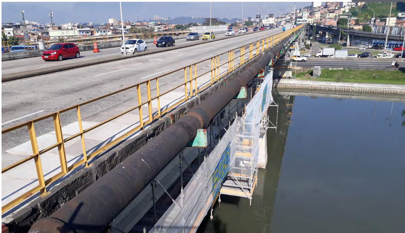
Obras na Ponte Oswaldo Cruz
