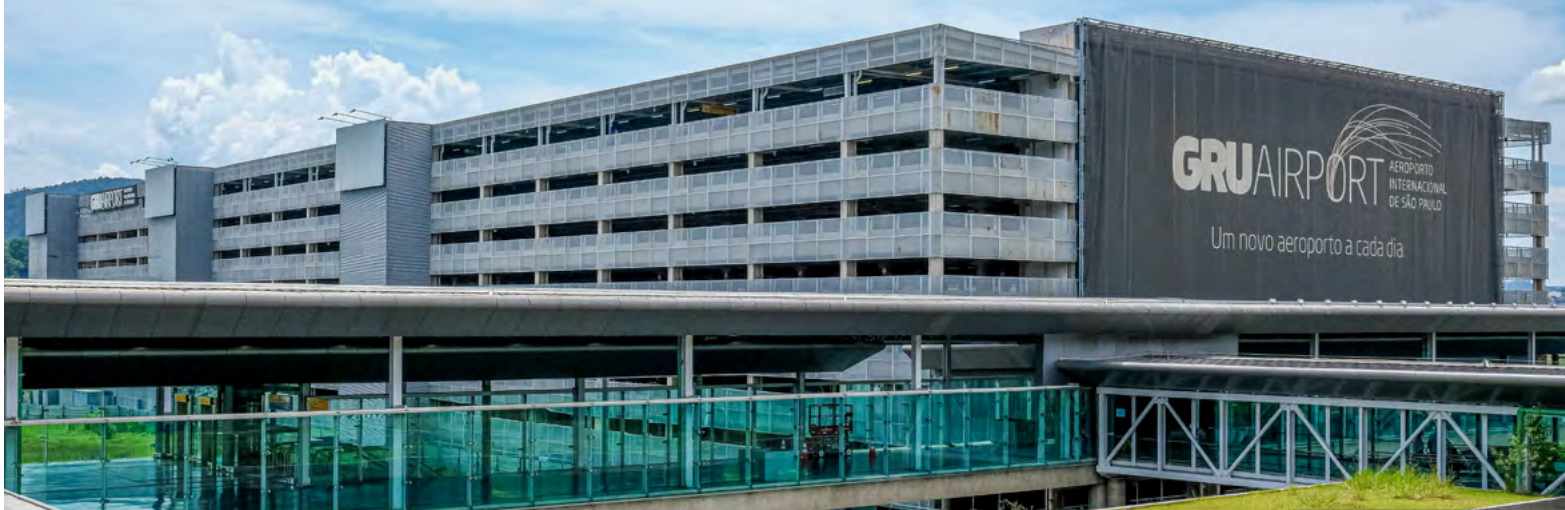
Fachada do aeroporto
