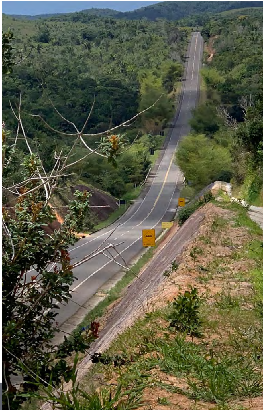
Trecho de rodovia sob concessão da CLN
