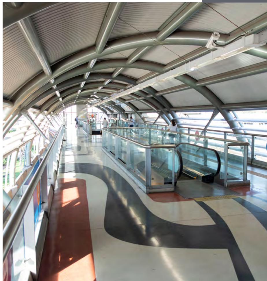
Estação de metrô Cidade Nova
