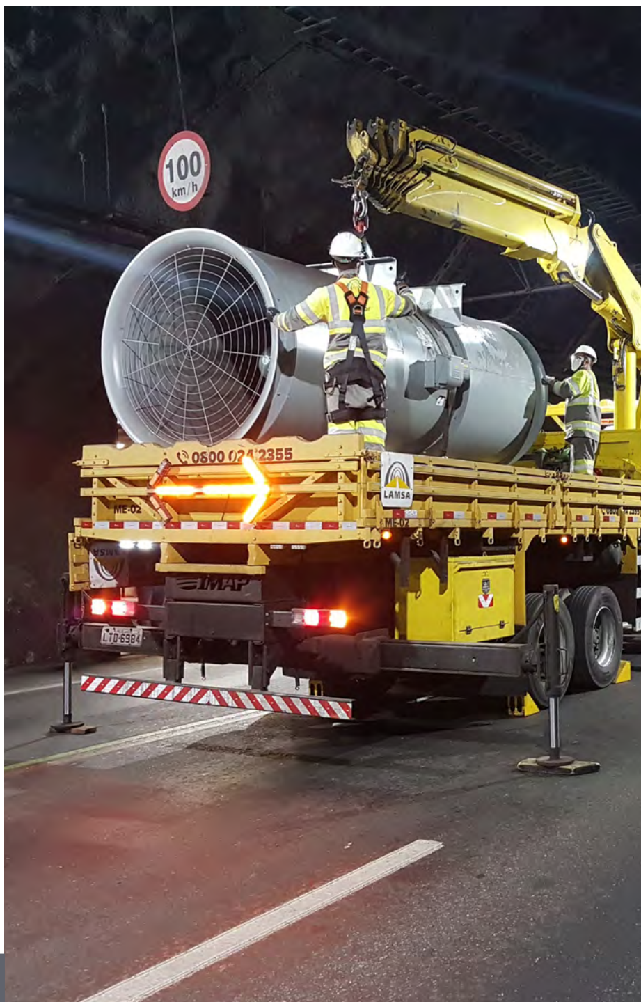
Obras de manutenção do túnel
