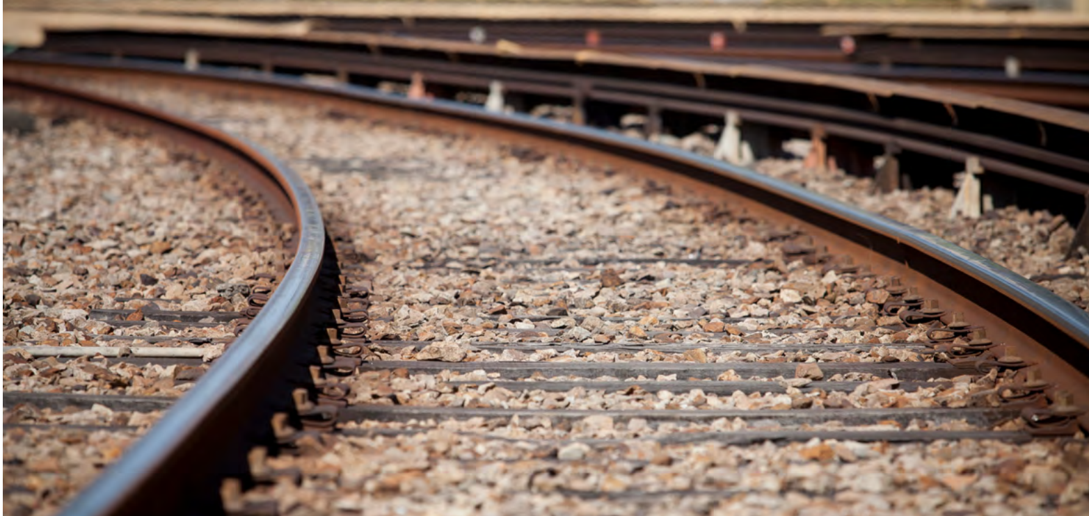
Trilhos do metrô
