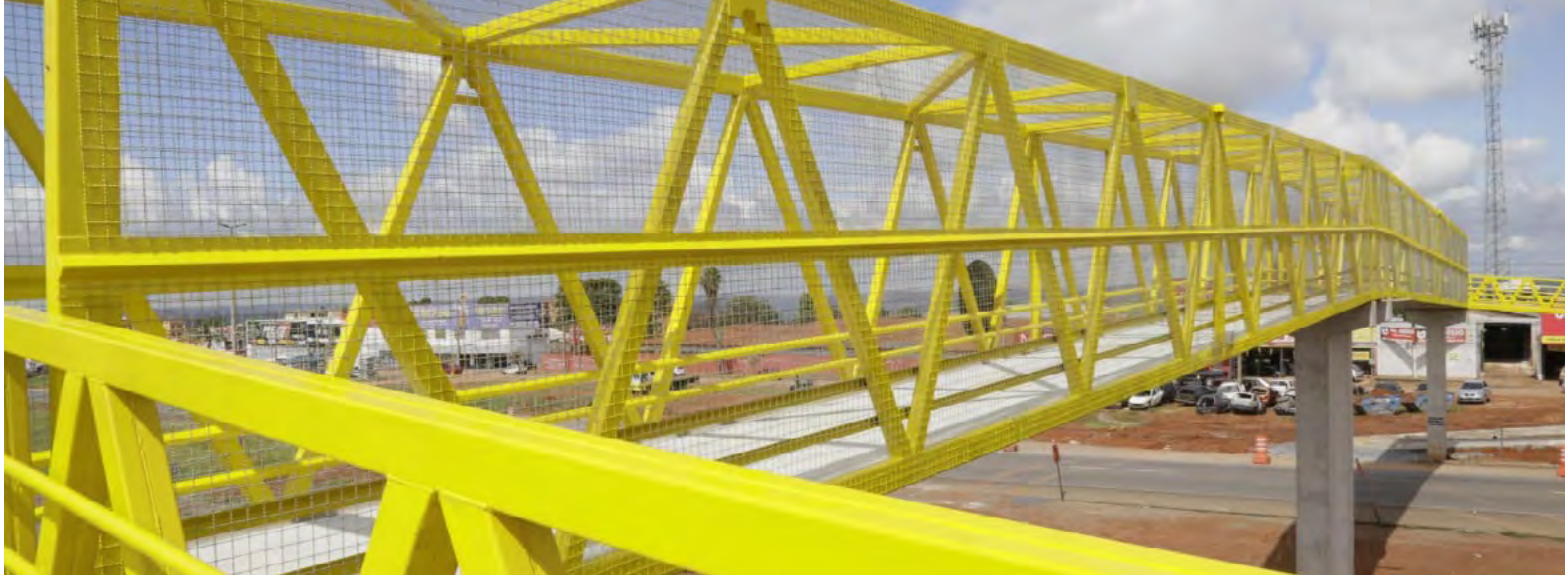
Passarela no km 4 em Valparaíso, Goiás
